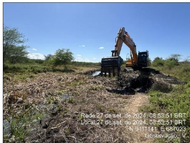
Foto 6.19: Desassoreamento e limpeza mecânica do canal de restituição do MV02.
