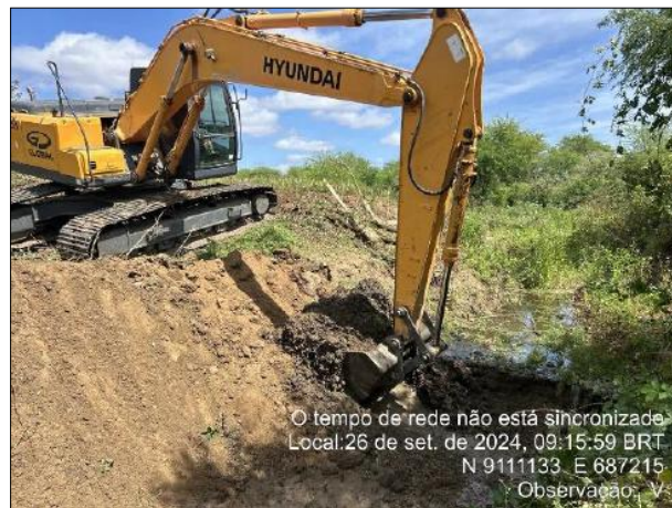
Foto 6.17: Desassoreamento e limpeza mecânica do canal de restituição do MV02.
