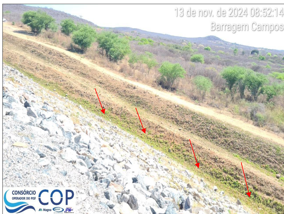
Foto 6.9: Regiões úmidas próximo ao pé do talude de jusante entre as estacas E-15+00 e E-19+00.
