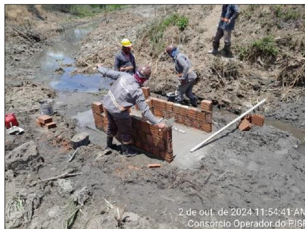
Foto 6.21: Execução do medidor de vazão MV02A instalado na estaca 9+12,80.
