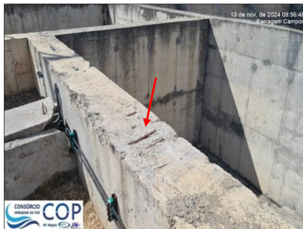
Foto 6.46: Ferragens expostas no concreto da estrutura de saída.
