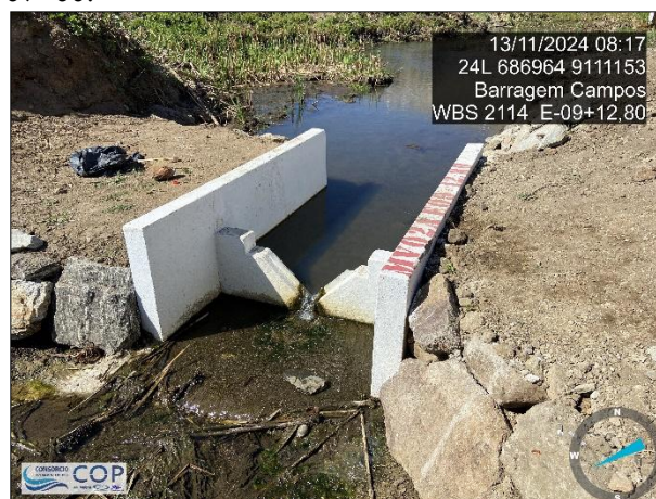
Foto 6.28: Medidor de vazão MV-02A na estaca 09+12,80.
