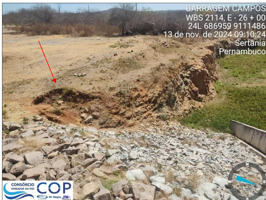
Foto 6.32: Falta de proteção de enrocamento e ocorrência de erosões no talude esquerdo do canal de restituição do vertedouro/tomada d'água.
