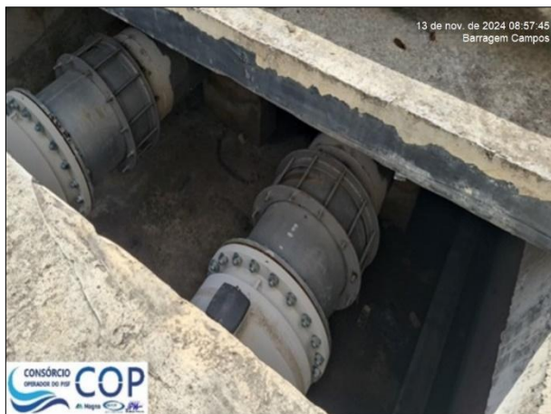
Foto 6.45: Tubulação da estrutura de saída com sinais pontuais de oxidação e sem dreno de fundo.
