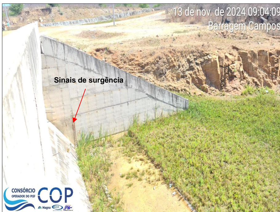
Foto 6.37: Muro lateral esquerdo do vertedouro, apresentando sinais de surgência.
