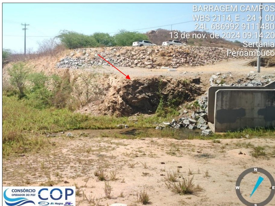
Foto 6.31: Falta de proteção de enrocamento e ocorrência de erosões no talude direito do canal de restituição do vertedouro/tomada d'água.
