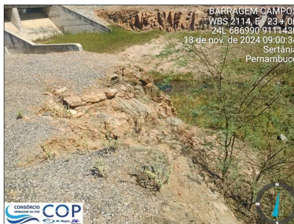
Foto 6.50: Erosões próximo à casa de comando.
