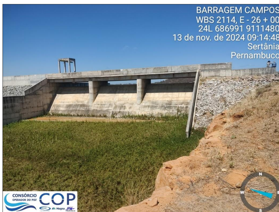
Foto 6.33: Vista da estrutura de fixação da soleira do vertedouro.
