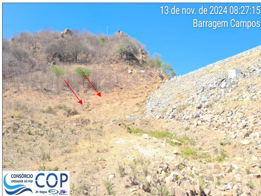
Foto 6.10: Processos erosivos na ombreira direita a jusante.
