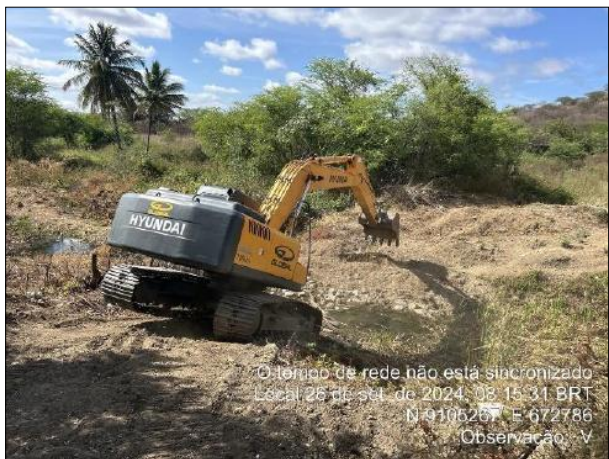
Foto 6.16: Desassoreamento e limpeza mecânica do canal de restituição do MV02.
