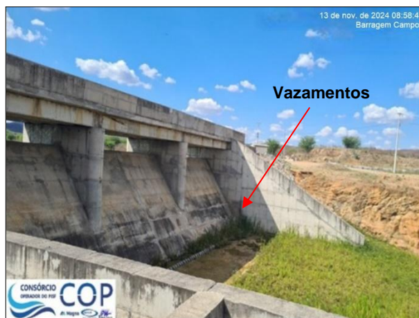
Foto 6.35: Vazamentos na estrutura de apoio da soleira do vertedouro.
