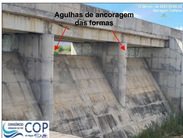
Foto 6.34: Agulhas de ancoragem das formas na estrutura de apoio da soleira do vertedouro.
