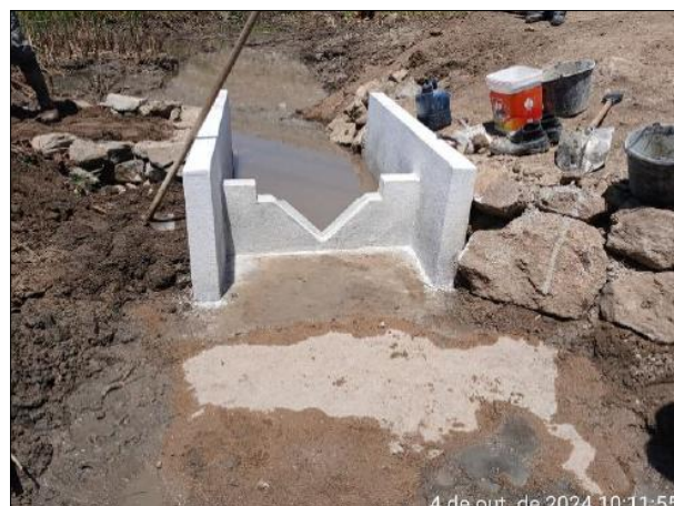
Foto 6.23: Execução do medidor de vazão MV02A instalado na estaca 9+12,80.
