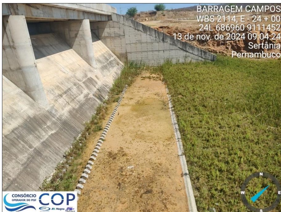
Foto 6.36: Presença de água e rebrotas na bacia de amortecimento.
