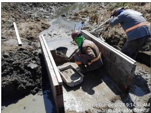
Foto 6.22: Execução do medidor de vazão MV02A instalado na estaca 9+12,80.
