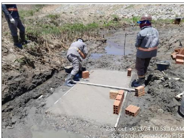
Foto 6.20: Execução do medidor de vazão MV02A instalado na estaca 9+12,80.
