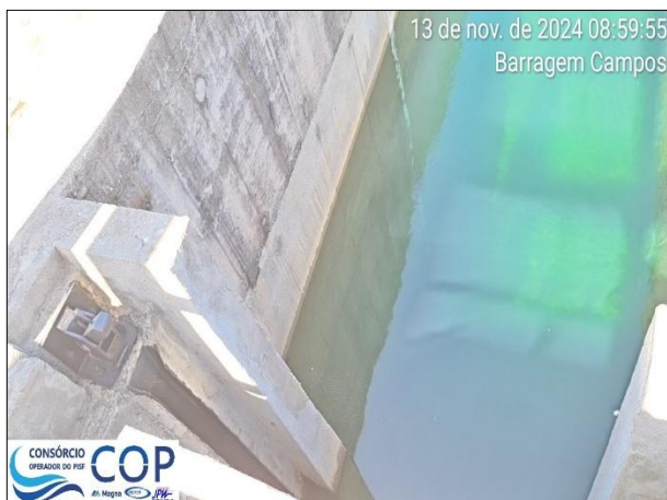
Foto 6.41: Guia de descida da comporta/grade em boas condições.
