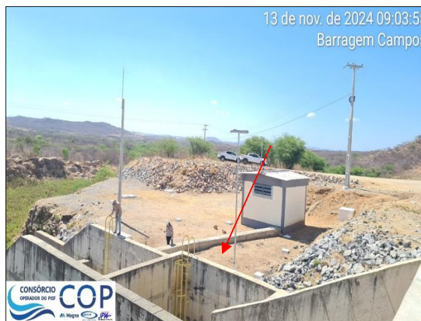
Foto 6.48: Falta de guarda-corpo de proteção na estrutura de saída da tomada d'água.
