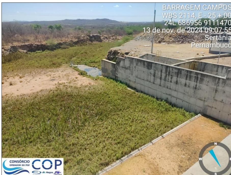
Foto 6.38: Muro lateral direito apresentando fissuras superficiais e mal acabamento do concreto.
