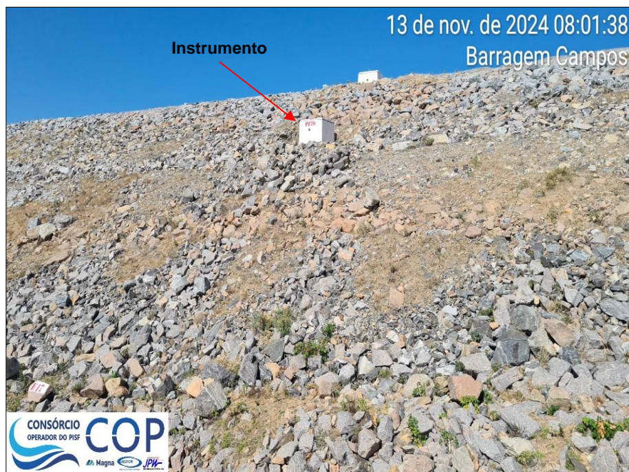
Foto 6.24: Falta de estrutura de acesso aos instrumentos da barragem.
