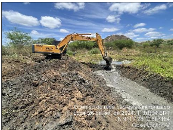
Foto 6.18: Desassoreamento e limpeza mecânica do canal de restituição do MV02.
