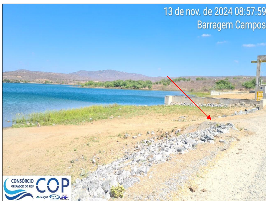
Foto 6.4: Talude de Montante – Rampa de acesso remanescente do período construtivo.
